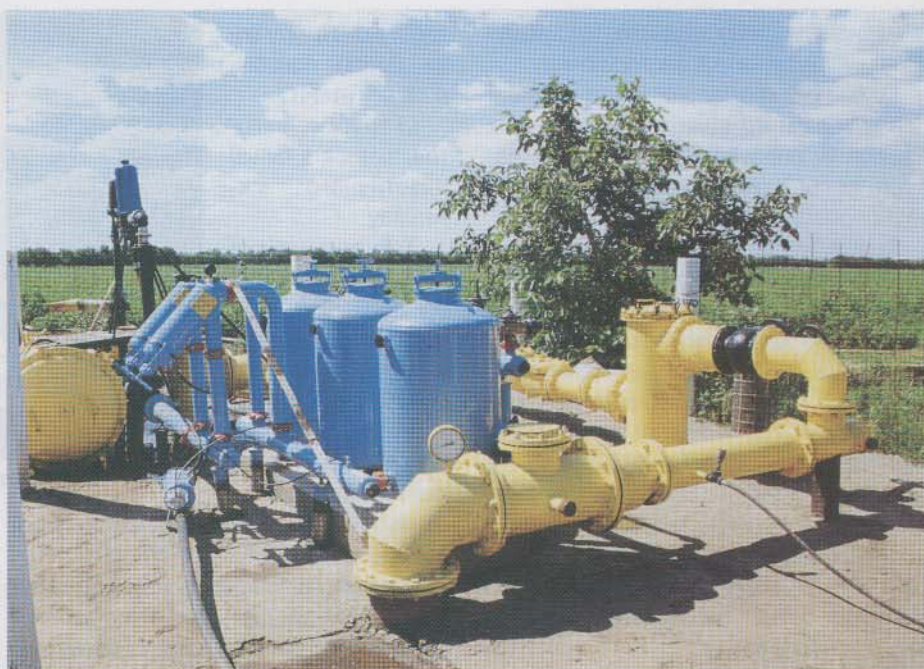
Насосно-фільтрувальна станція
